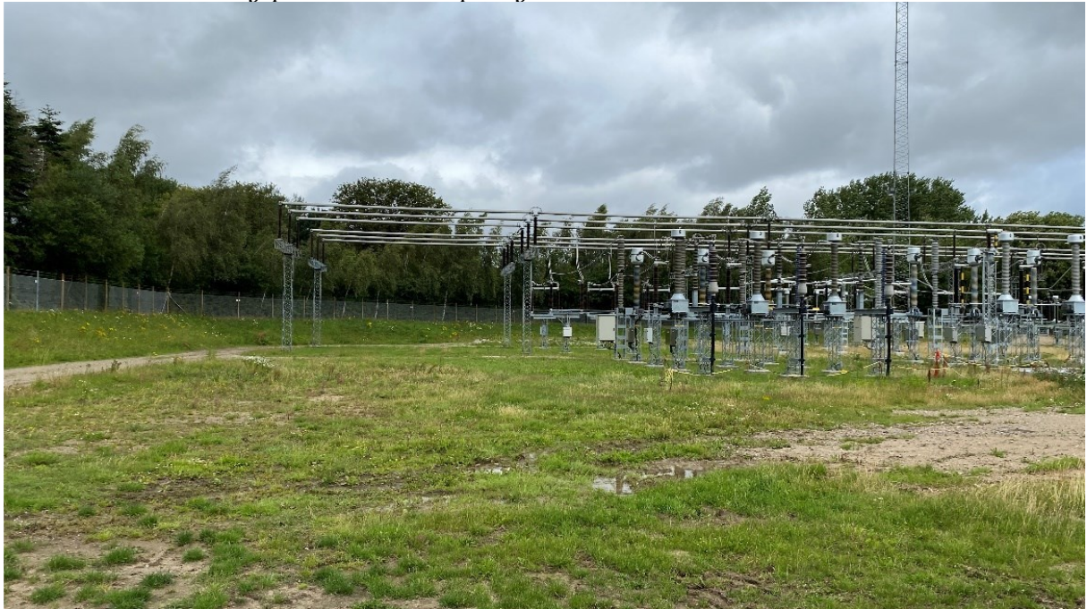
Figur 2 - Visualiseringspunkt nr. 1 fra Figur 1. Flytning af eksisterende kabelfelt, set fra syd. Eksisterende kabelfelt markeret med grøn og flyttes til det tomme koblingsfelt vest for.
